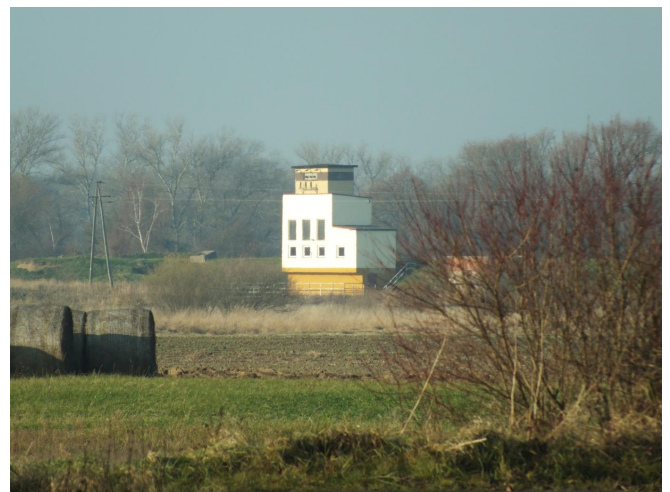
Fot. 8. Borków - przepompownia wody
