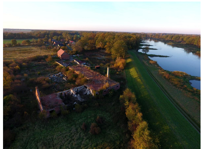
Fot. 28. Zespół dworski w Mieszynie - zrujnowany jeden z budynków gospodarczych, na drugim planie użytkowana oficyna
