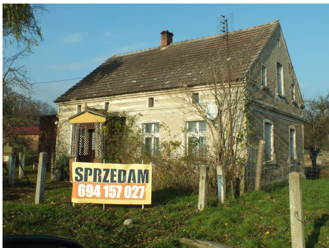
Fot. 9. Borków nr 35 - dom mieszkalny
