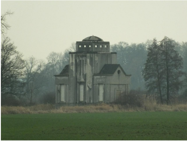
Fot. 41. Przepompownia w Leszkowicach
