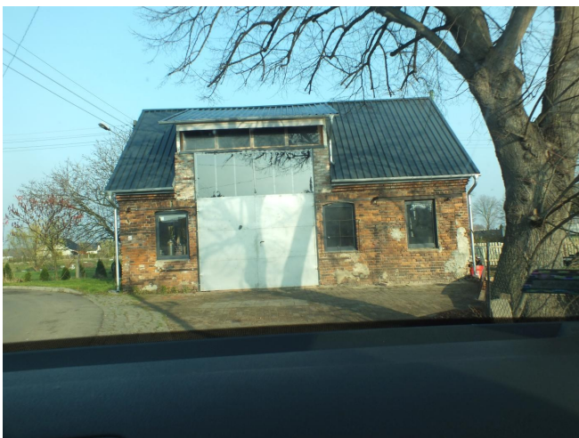
Fot. 7. Białotłęka - kuźnia po przebudowie
