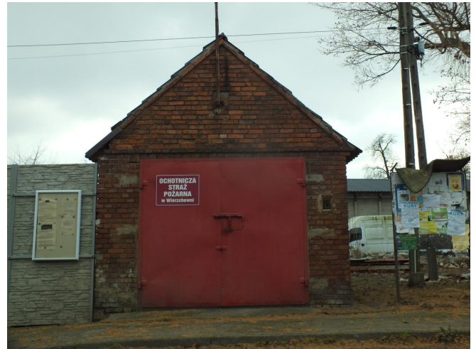
Fot. 34. Remiza strażacka w Wietszycach
