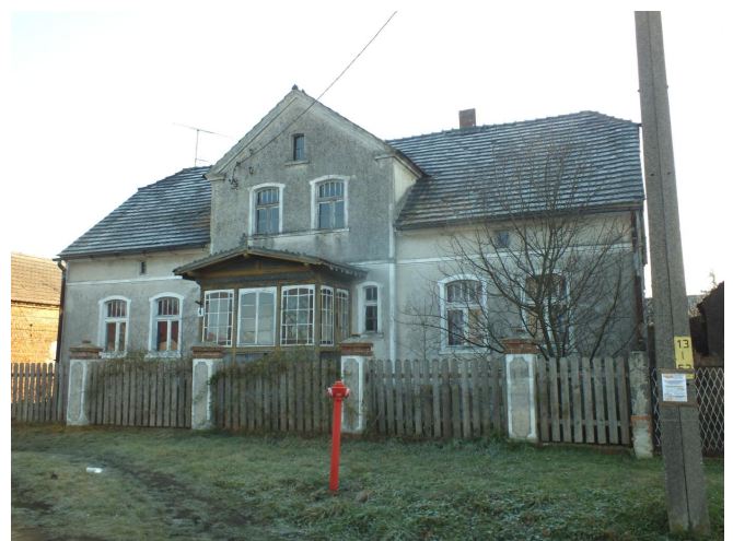
Fot. 36. Wojszyn nr 4 - dom mieszkalny
